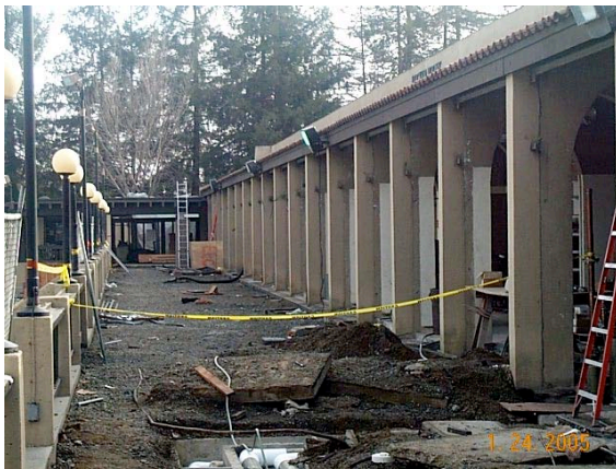
PE Quad Exterior East Facing
